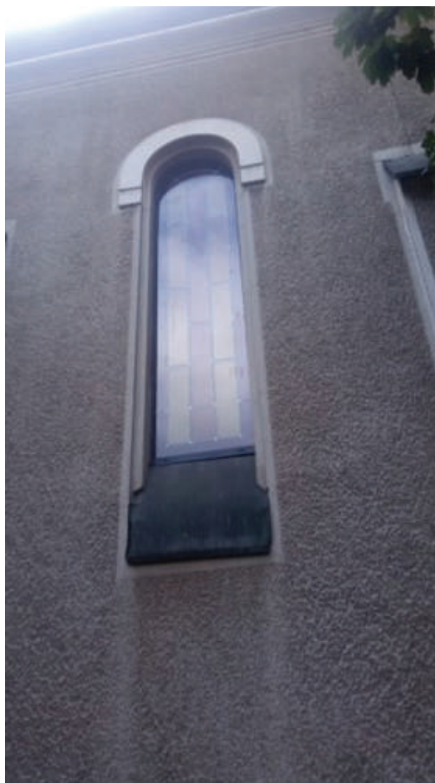
Слика број 137. Детаљ прозора.
