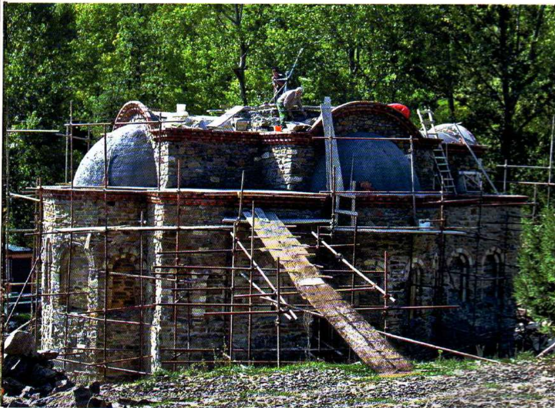
137 Манастир Дренча, црква, изглед са севера, армиранобетон луске изведене на полукалотама кровни венци (2003)
