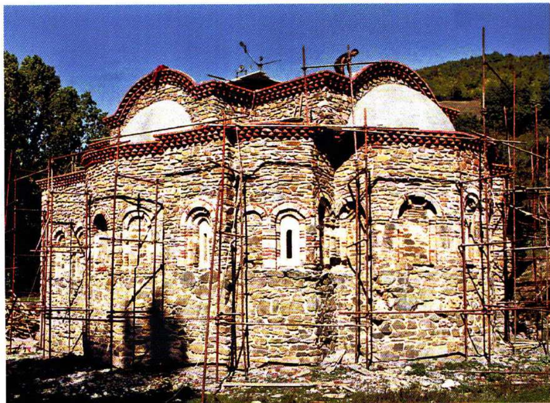
Манастир Дренча, црква, вид са југоистока, армиранобетонске луке изведене на полукалотата и луке венци (2003)
