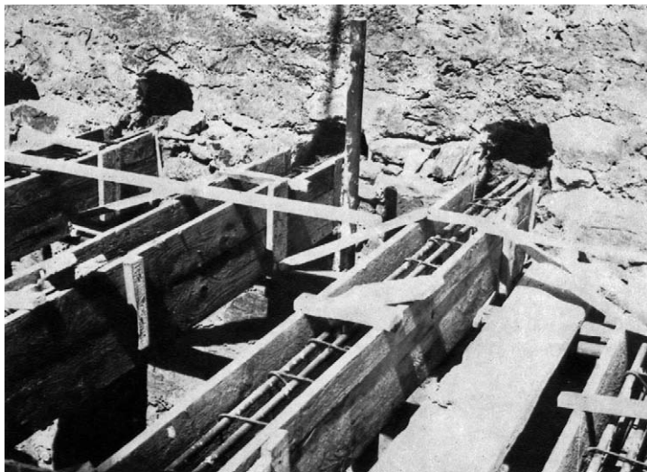
Sl. 3. Detalj spratne konstrukcije u toku izvođenja konzervatorskih radova
