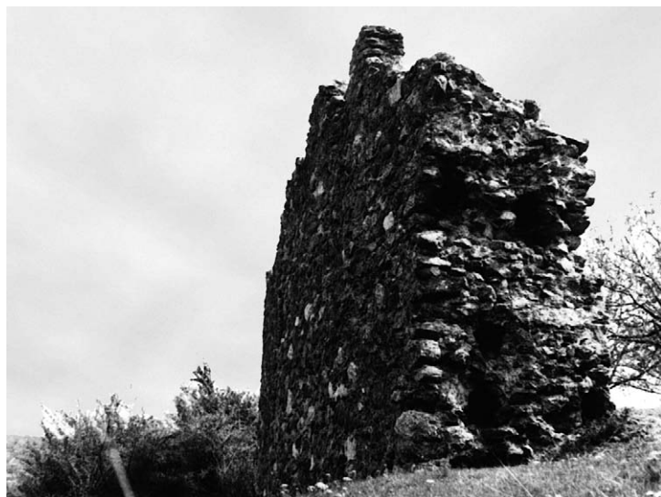
Sl. 15. Stalac, deo bedema Velikog grada kod kapije, spoljna strana sa tragom parapeta zubaca i šetnom stazom
