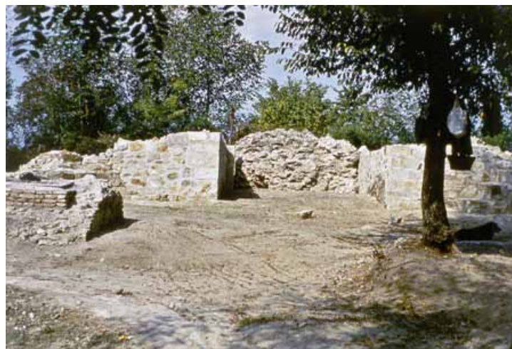
Sl. 28. Stalać, zazidana kapija kroz kulu II između Velikog i Malog grada, izgled posle konzervacije
