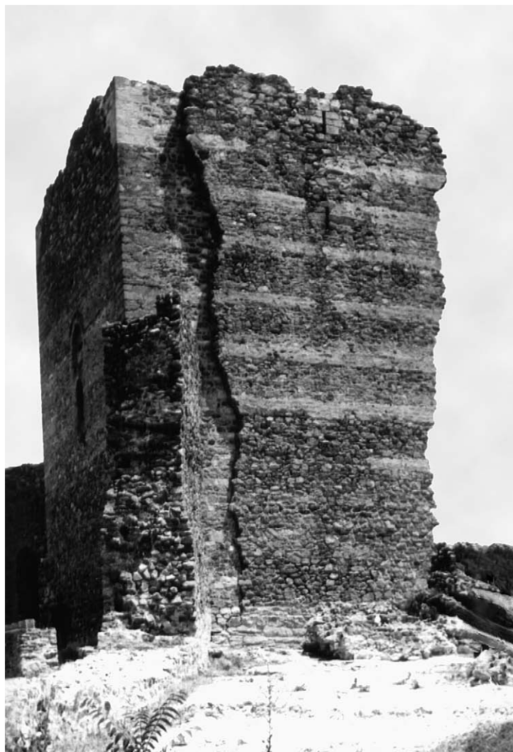
Sl. 12. Stalac, glavna – donžon kula, zapadno zidno platno sa tragovima oslikanih redova opeka
