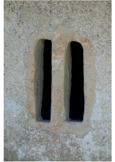
Отвори за вентилацију/ луфти на подруму, пољана Калуђерско Брдо
