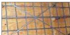
Slika 112. Gvozdена armatura pre betoniranja, dokumentacija GSSI.
