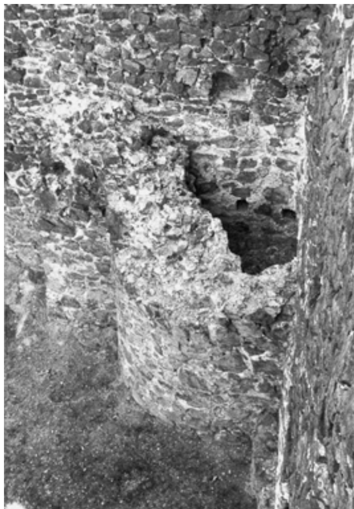
Sl. 76. Palata, supstrukcija ugaonog kamina (foto iz 1985. g.)
