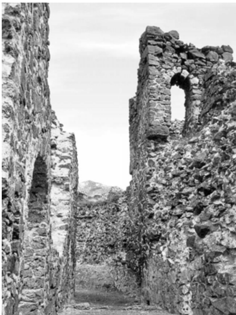
Sl. 14. Kula II, stanje pre obnove
