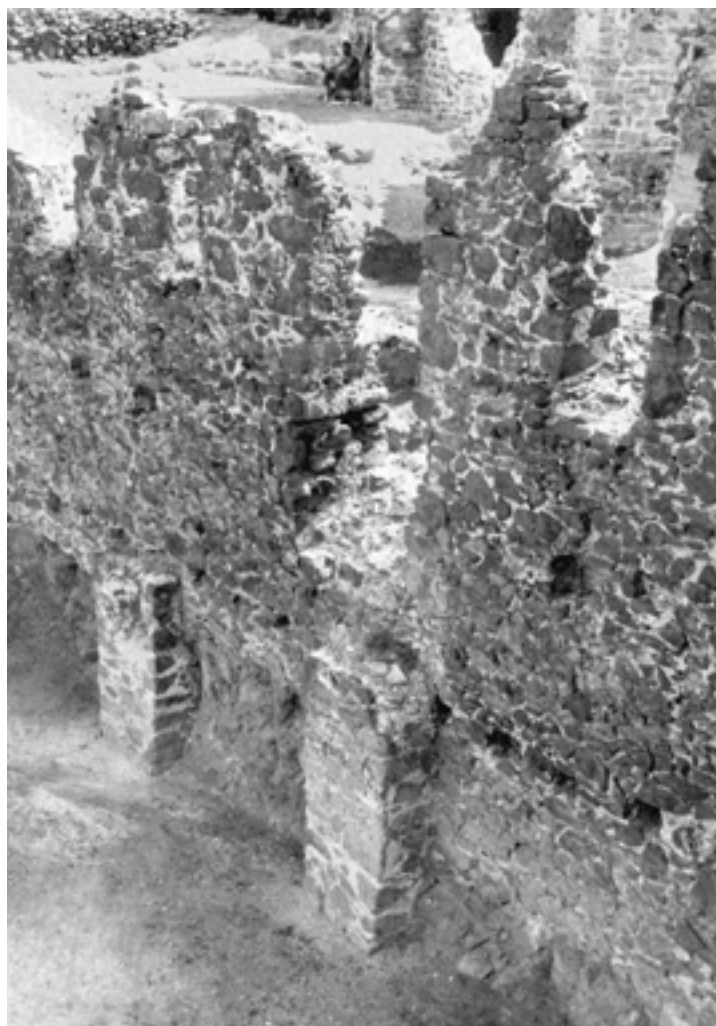
Sl. 76. Palata, supstrukcija ugaonog kamina (foto iz 1985. g.)
