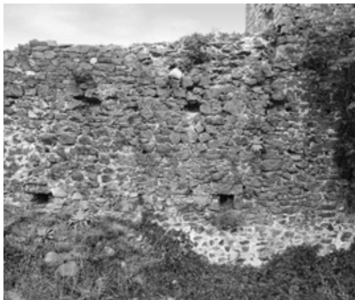
Sl. 92. Severozapadna građevina, lice Zapadnog bedema sa propustima za vodu i tragovima ležišta međuspratne konstrukcije (foto iz 2010. g.)
