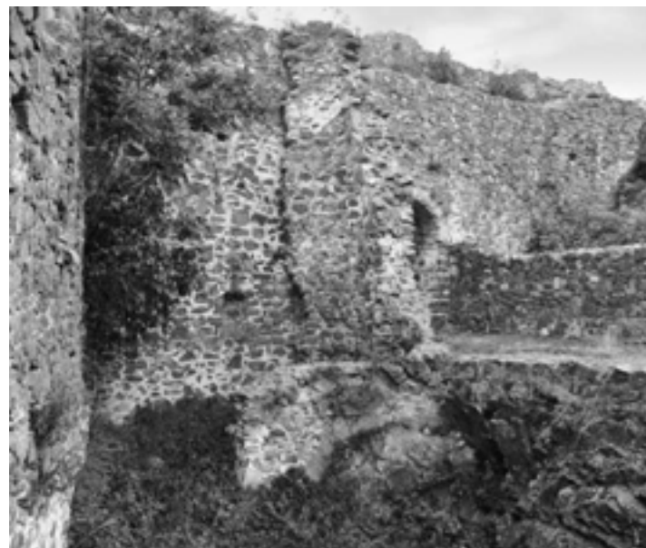
Sl. 92. Severozapadna građevina, lice Zapadnog bedema sa propustima za vodu i tragovima ležišta međuspratne konstrukcije (foto iz 2010. g.)
