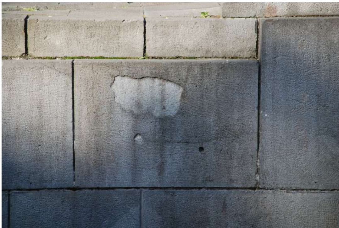
Оштећење површинског слоја камена на доњем делу постамента
