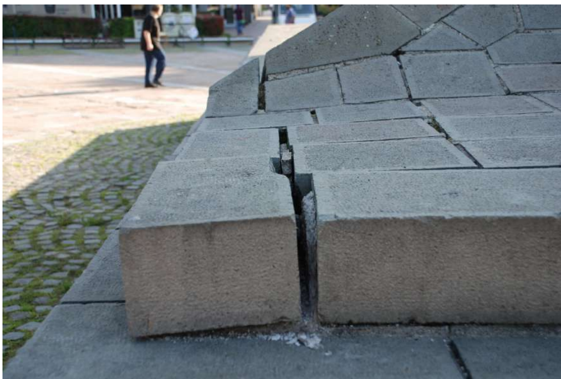
Одвајање камених блокова од подлоге на западном углу постамента
